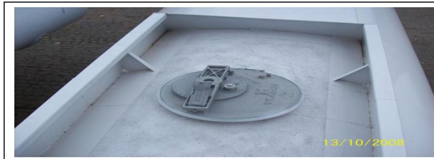
**Figura 22** – - Tampa de inspeção e carga/ válvula de vácuo e pressão.
