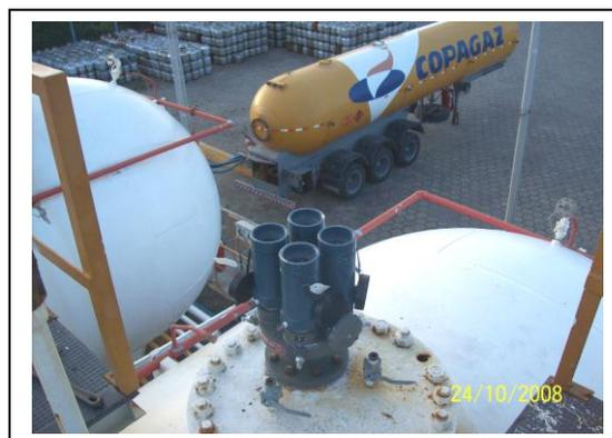
**Figura 30** – Válvula de segurança e equipamento rodoviário para transporte de GLP.
